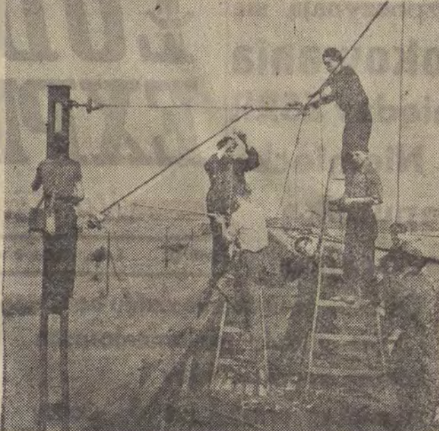
Największe nasilenie prac przy budowie traktacji elektrycznej na linii kolejowej Warszawa — Stalinogród, trwa obecnie na odcinku Płotków Trybunalski — Częstochowa. Na zdjęciu: regulację sieci trakcyjnej na odcinku stacji Radomsko przeprowadza przodująca brygada Stanisława Plegiuta. CAF — fot. Szyperko
