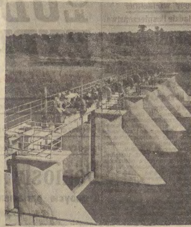
Uruchomienie rurociągu nastąpi w listopadzie br. Na zdjęciu: stacja ujęcia wody na Pilicy. CAF — fot. Tyminski
