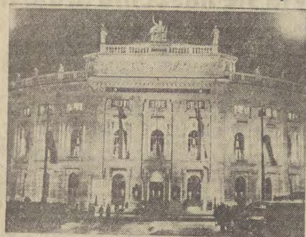
14 października br. odbyło się uroczyste otwarcie odbudowanego wiedeńskiego Burgtheater. Na zdjęciu: gmach teatru, odbudowany dokładnie wg planów jego budowniczych Sempers i Hausenauera. Fot. — CAP.
