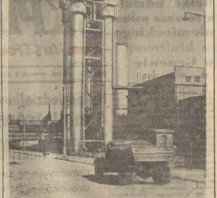
Fragment zakładów koksochemicznych, na pierwszym planie wieża benzolowni. fot. CAF
