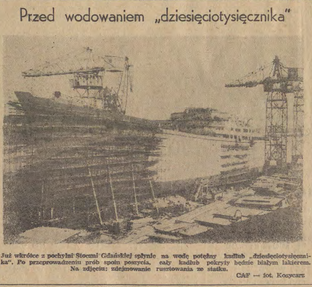
Już wkrótce z pochylni Stoczni Gdańskiej spłynie na wodę potężny kadłub „dziesięcioletnika”. Po przeprowadzeniu prób spinu pozycja, cały kadłub pokryty będzie białym lakierem. Na zdjęciu: zdejmowanie rusztowania ze statku.
