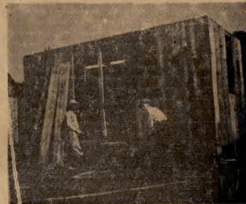
Budowa domu na kolonii
