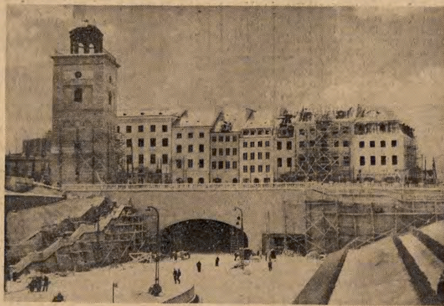
Widok z pałacu „Pod Blachą” na wlot do tunelu Trasy W — Z.
