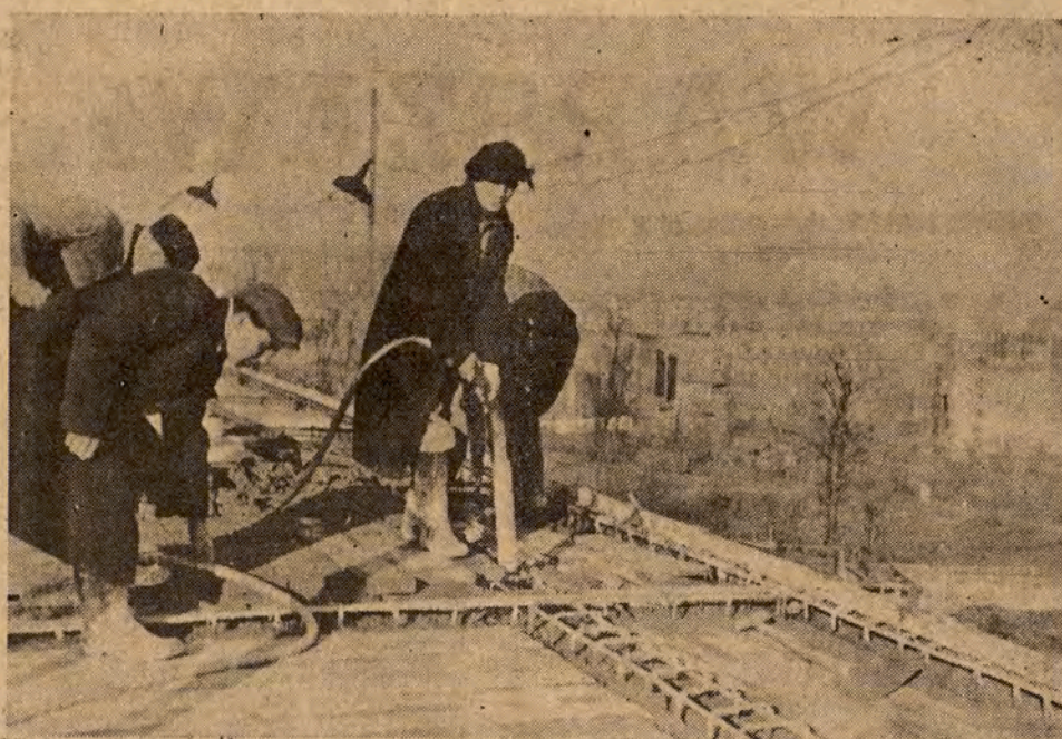
Rozbudowa gmachów sejmowych w Warszawie
