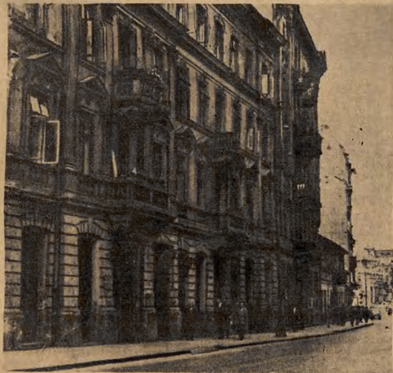
Czynszowe, mieszczańskie kamienice na Wilczej z lat 90-tych
