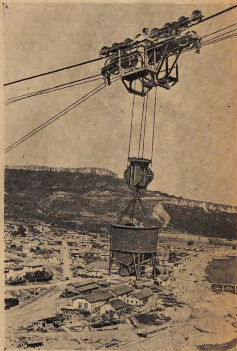
Budowa zapory wodnej
