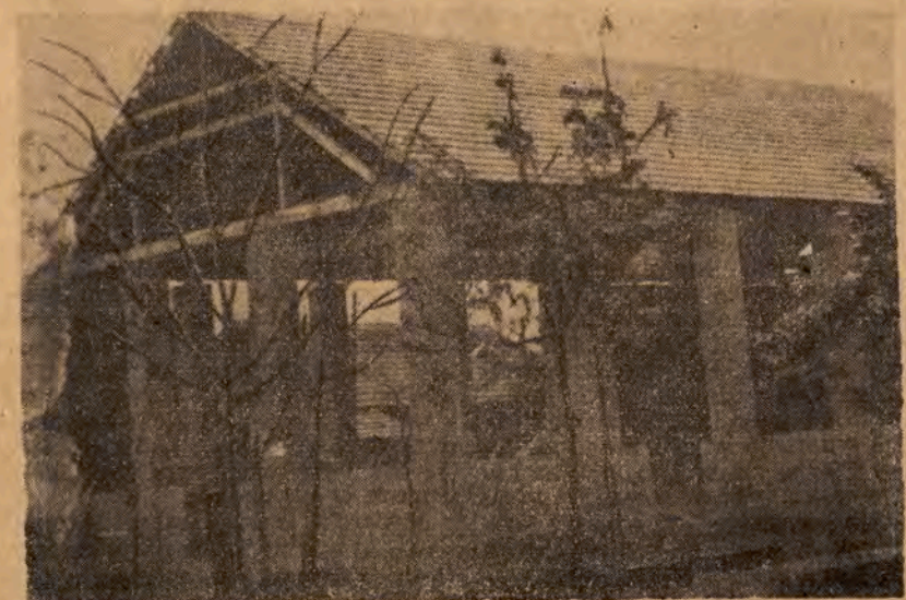
Budowa Domu Ludowego we wsi Wola Wielka pow. Łanucki.
