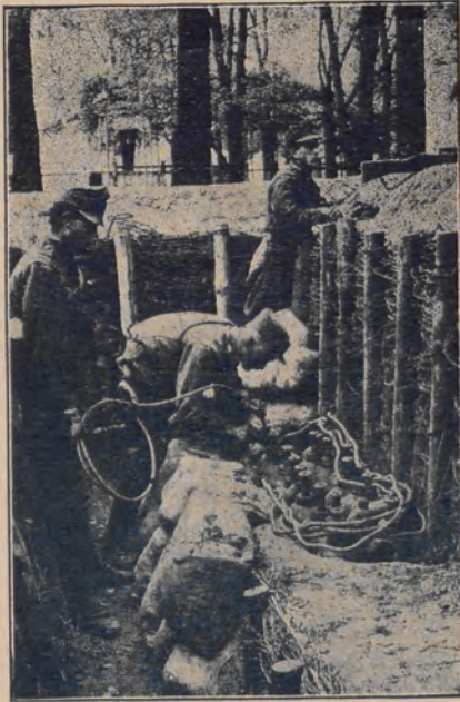
Austrjaccy saperzy montują baterję butli z chlorem do napadu gazowego.
