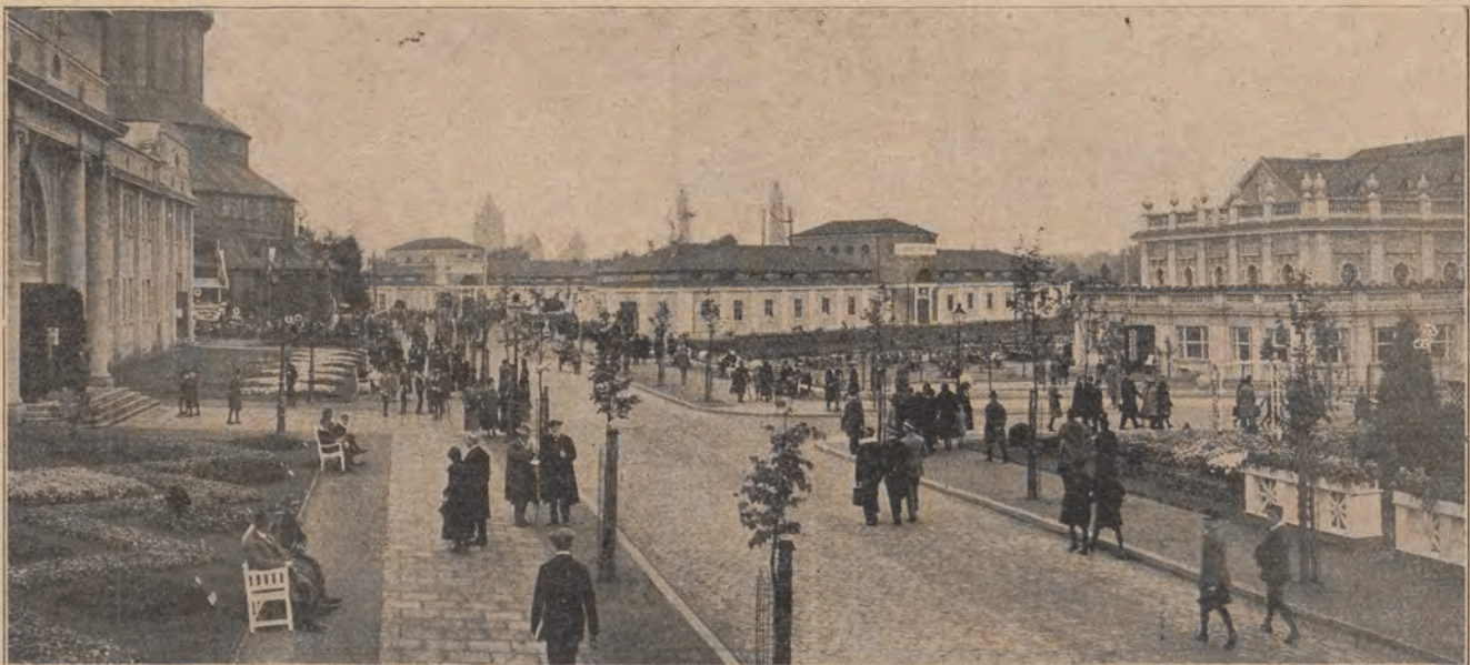
Teren Targów Poznańskich, gdzie będzie mieściła się wielka wystawa przeciwpożarowa w czasie Zjazdu Strażackiego. Jak widzimy piękny teren Targów doprowadzony dzięki energii Dyrekcji Targów do tak imponującego wyglądu — stanowić będzie efektowne tło dla wystawy pożarniczej.
