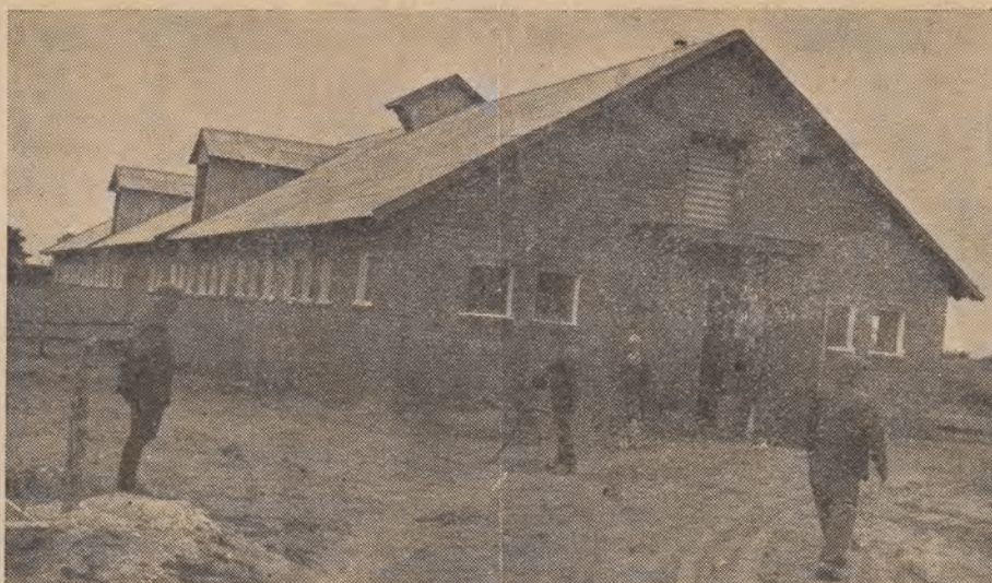
Nowa obora w spółdzielni produkcyjnej Rąbień, pow. łódzkiego
