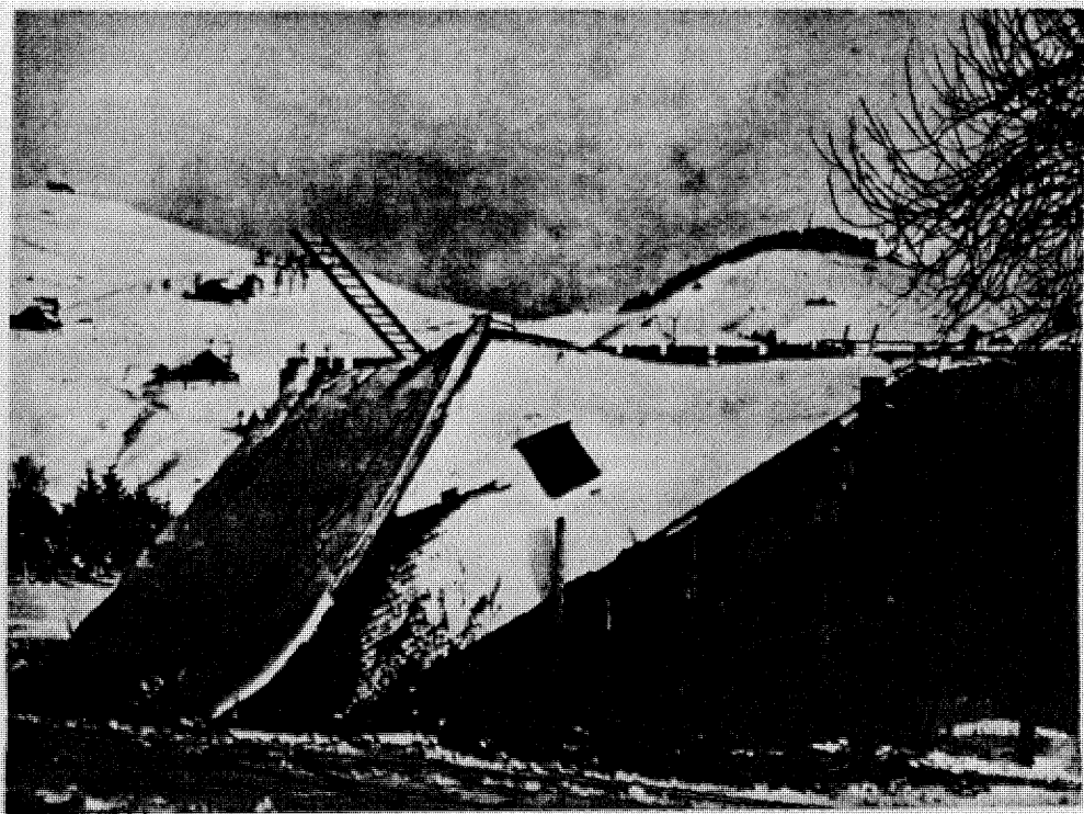
Orkan, jaki w zeszłym tygodniu szalał w północnych kantonach Szwajcarii, wyrządził dotkliwe straty i szkody. Zdjęcie przedstawia jeden z wielu zburzonych domów.
