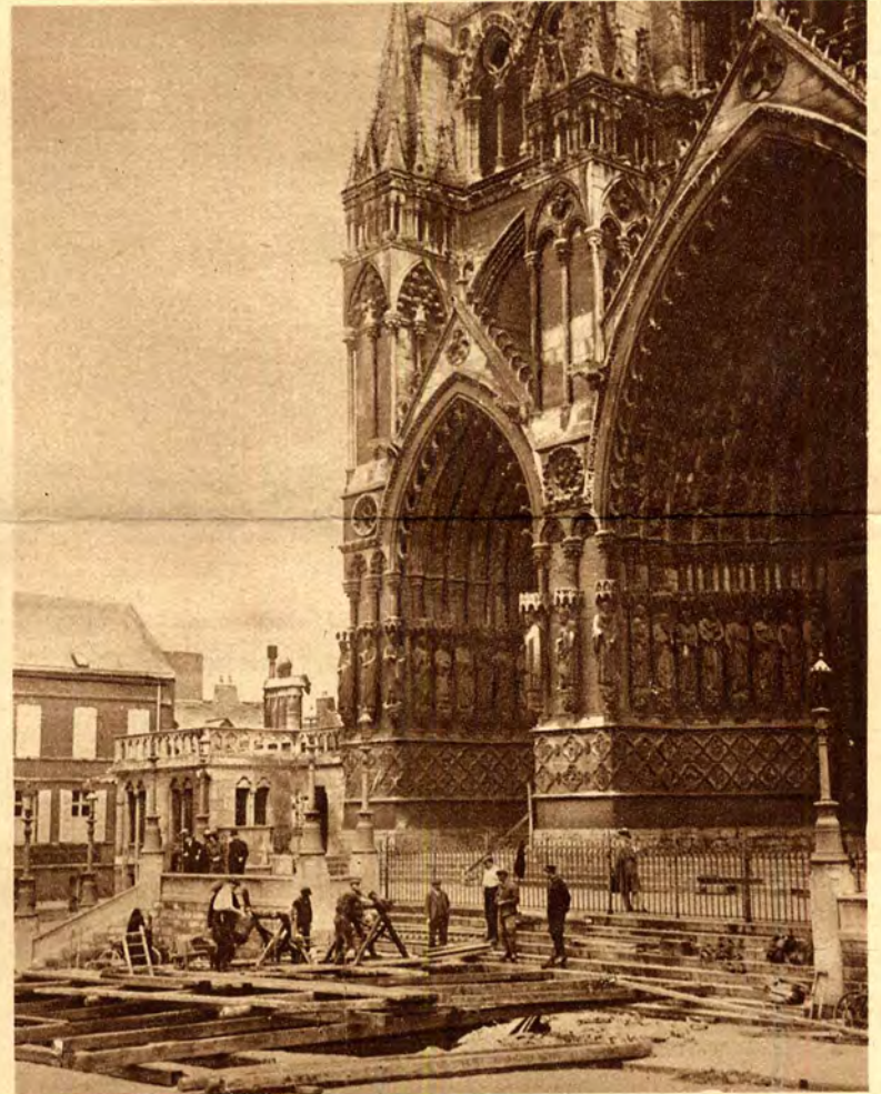
Wielka rozpadlina (7 metrów średn.) utworzyła się z niewiadomej przyczyny przed portalem katedry w Amiens (Francja), grożąc jej ruiną. Zdjęcie przedstawia robotników, usiłujących zapobiec możliwej katastrofie.
