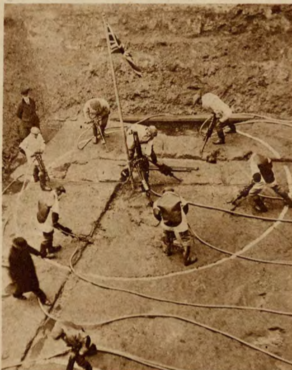
W ten sposób rozpoczęto niedawno w Anglii budowę największego tunelu pod rzeką Mersey. Tunel ten długości ponad 3 klm., wymaga usunięcia co najmniej miliona ton skały. Na zdjęciu widzimy, jak robotnicy uzbrojeni w pneumatyczne świdry, rozpoczynają walkę z opoką.
