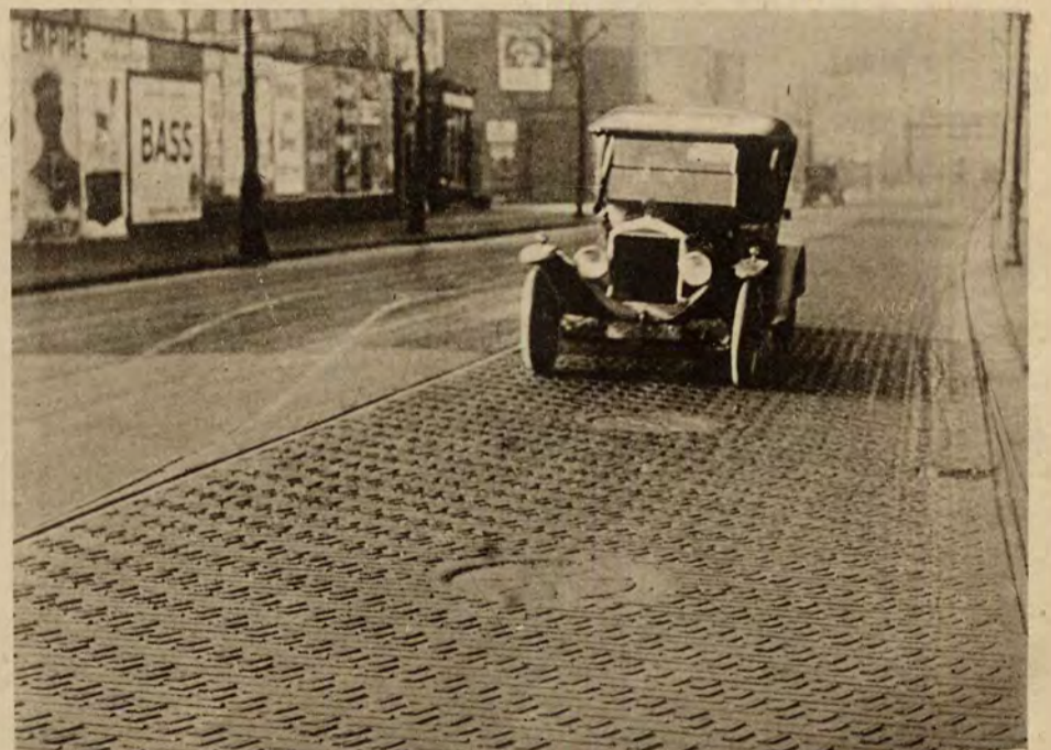
Ciekawą drogę zbudowano w Acton (Anglja) dla samochodów w celach eksperymentalnych. Droga wyłożona jest drewnianą kostką, która przykryta jest gumowymi paskami. Dotychczasowe wyniki są zupełnie zadowalające.
