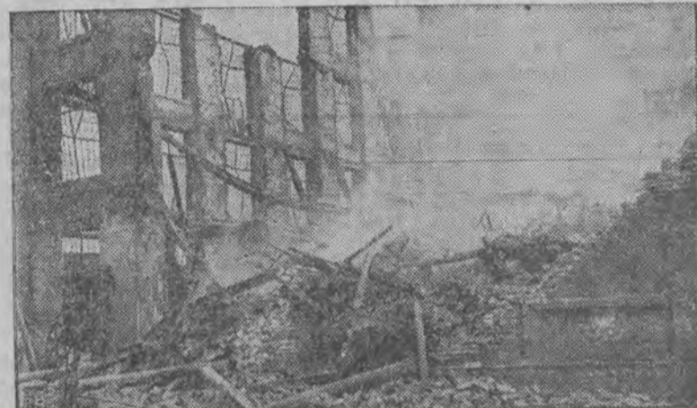
Dogasające zgliszcza wielkiego gmachu fabrycznego, w których znajdują się szczątki trzech ofiar.
