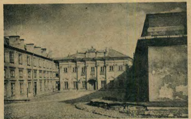
Pałac „Pod Błachą”, przeznaczony na urządowanie dla Marsz. Piłsudskiego.
