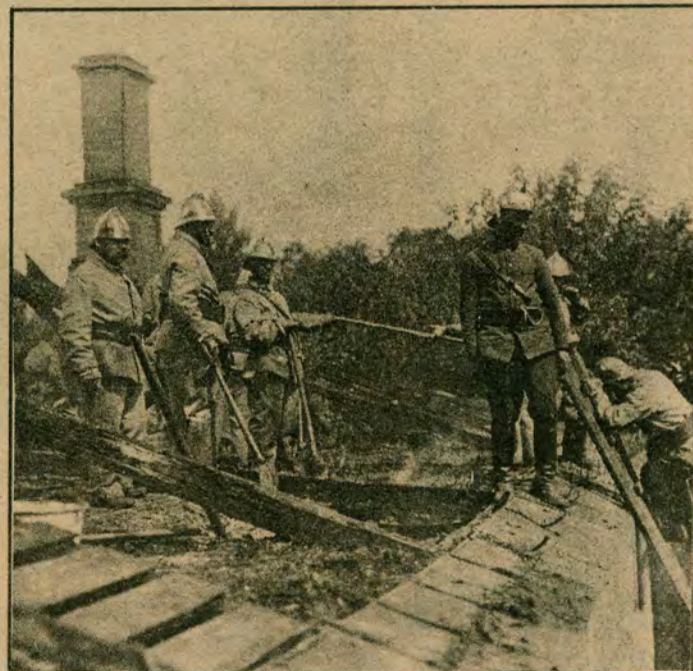
Pożar szpitala obłąkanych w Drewnicy.
