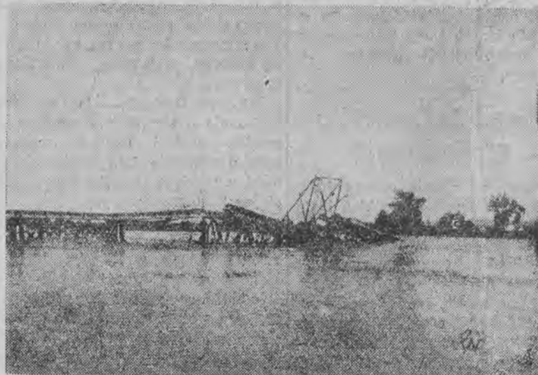
Jeden z zerwanych mostów kolejowych pod Krakowem.
