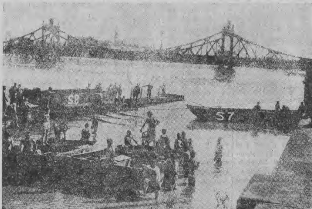
W akcji ratowniczej na terenach nawiedzonych katastrofą powodzi bierze żywy udział wojsko, pracując bez wytęchnienia dniem i nocą. Na zdjęciu saperzy podczas akcji ratowniczej pod Krakowem. Budowa mostów pontonowych.
