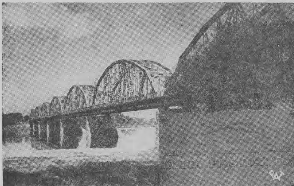
W ubiegłą niedzielę odbyło się uroczyste poświęcenie mostu im. marsz. Józefa Piłsudskiego na Wiśle pod Modlinem. Na zdjęciu — ogólny widok mostu. Z boku — tablica wmurowana w przyczółek mostu.
