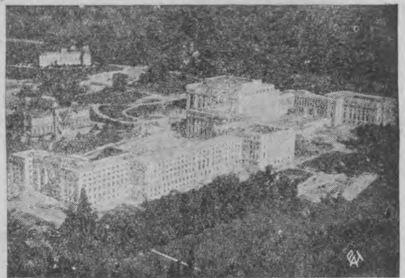
Zdjęcie z lotu ptaka nowego pałacu ligi narodów w Genewie, jednego z najokazalszych budynków czasów nowoczesnych w Europie.
