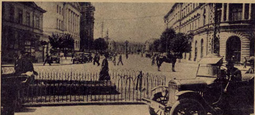
Obecny widok na Plac Saski w Warszawie.
