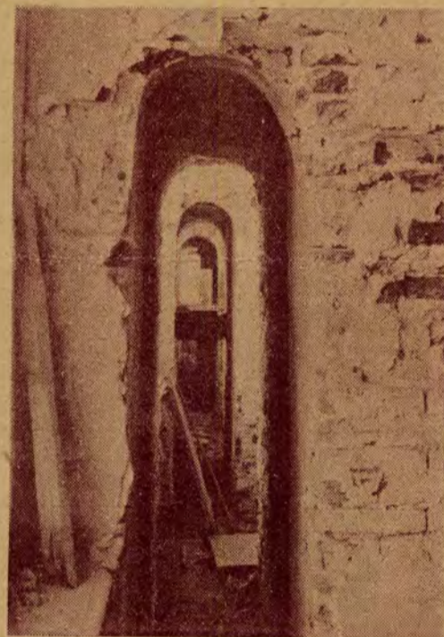
Podczas prac przy odnawianiu odnaleziono zamurcwaną przez Rosjan przejście, służące jako korytarz Wielkiej Sali Sejmowej.
