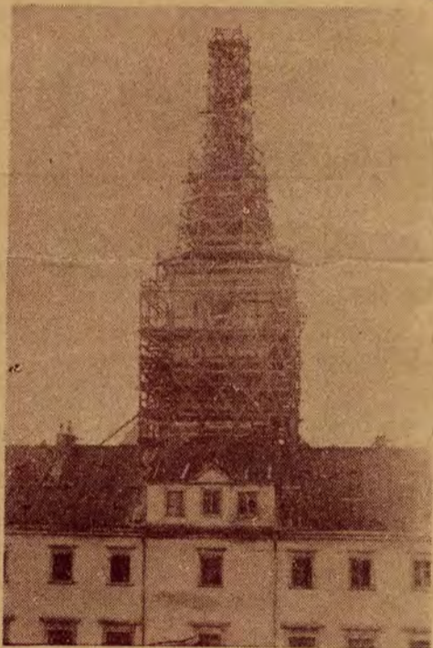
Remont wieży zegarowej.
