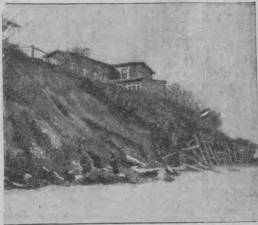
Fale podmyły brzeg, który ludność usiłuje umocnić palami i drabiami.
