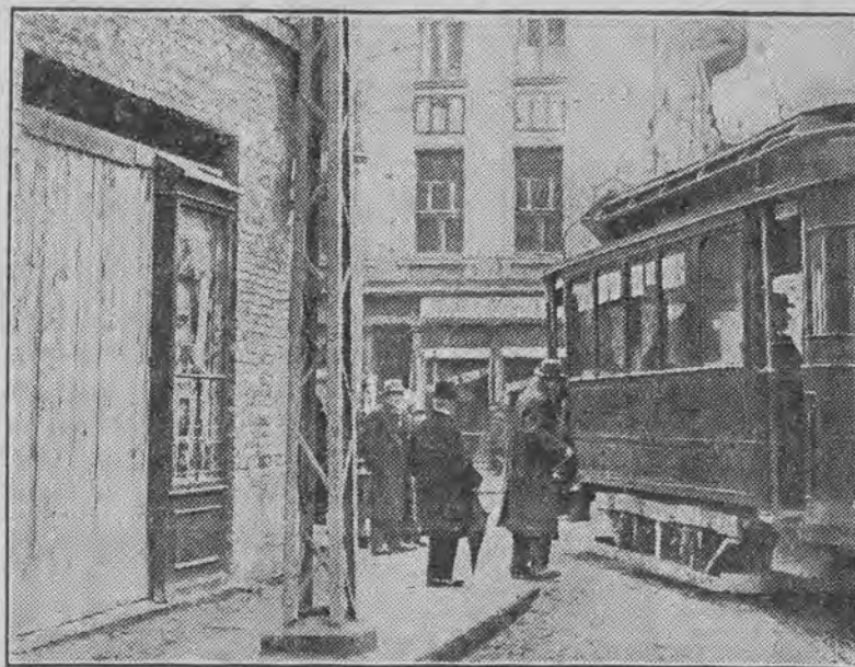
Róg Piotrkowskiej i Główniej — jaskrawy przykład skandalicznej polityki budowlanej.
