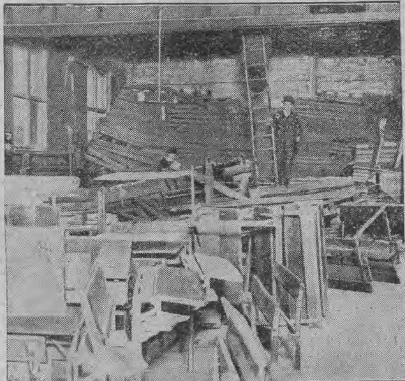
sawaliła się podłoga, przyczem 300 osób spadło 8 metrów w dół. 211 osób odniosło rany.
