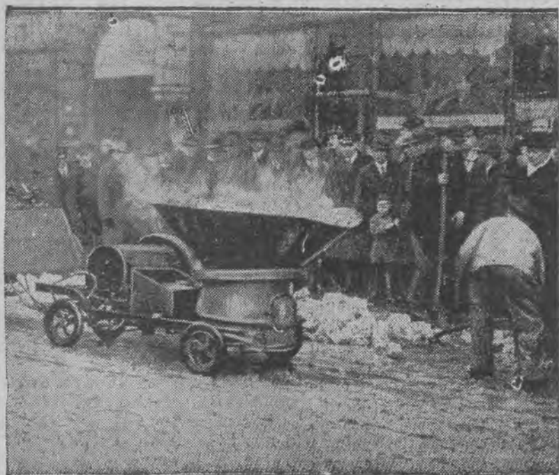
Robotnicy miejscy „spalają” w specjalnych kociach leżący na jezdni śnieg.
