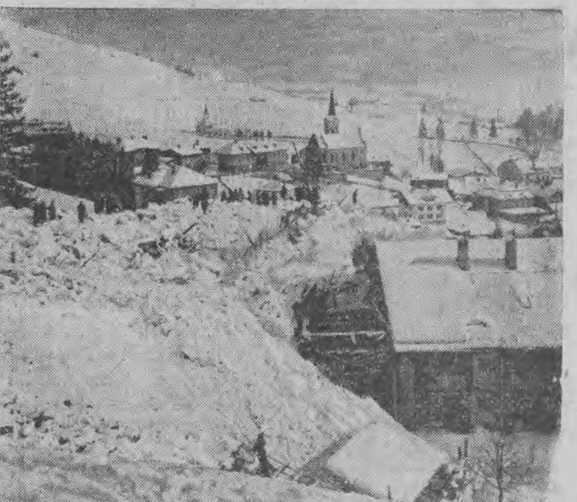
Wieś Mühlau w pobliżu Insbrucku została w połowie zasypana
