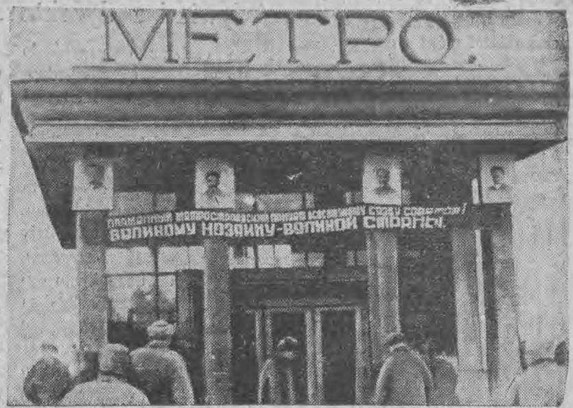
Stacja kolej podziemnej „Smolenskaja”.
