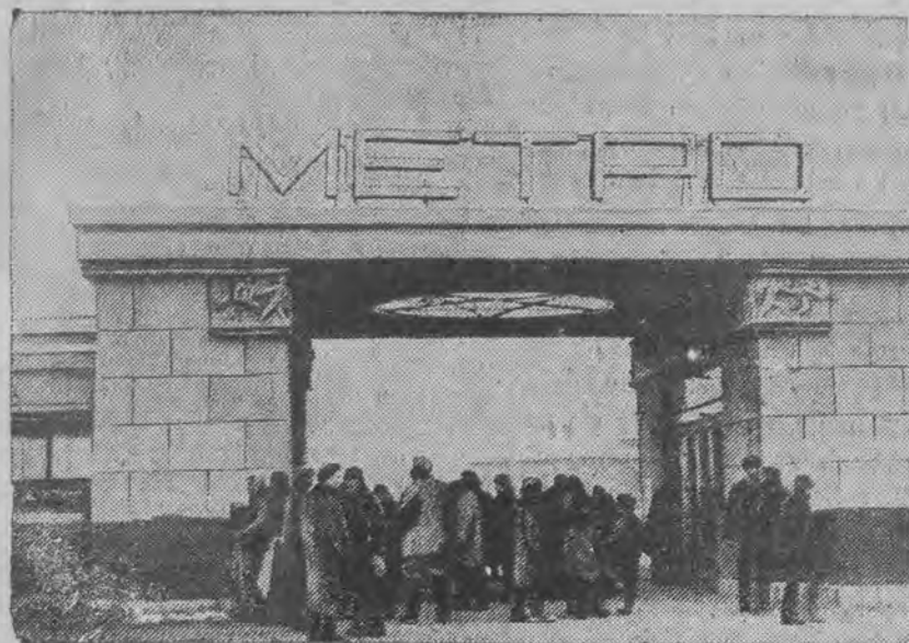
Wejście do stacji Metrostroju „Sokolniki”.
