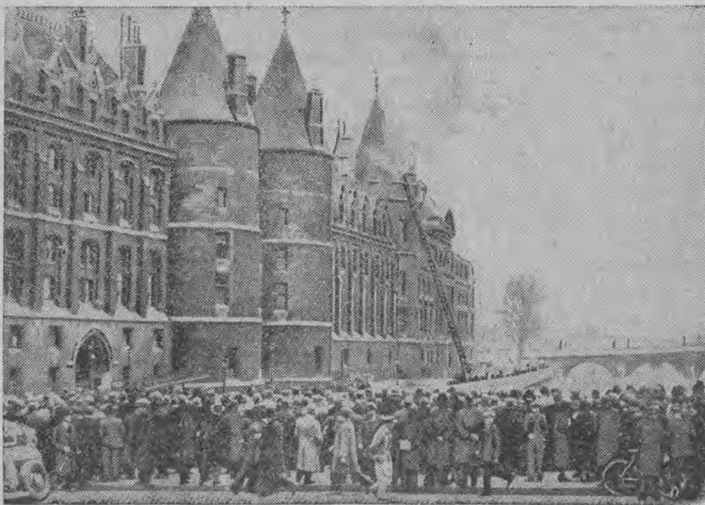
Splonęła wieża, w której więziono ongiś Marję Antoninę przed straceniem.
