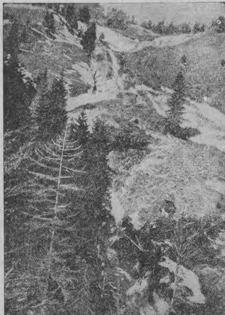
która zagraża położonym u jej stóp wioskom pod Oberdudorfem nad rzeką Inn.
