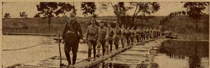
Przeprawa po kładce.
