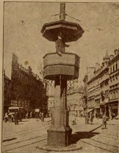
Wieża zbudowana w Chemnitz do regulowania ruchu ulicznego.
