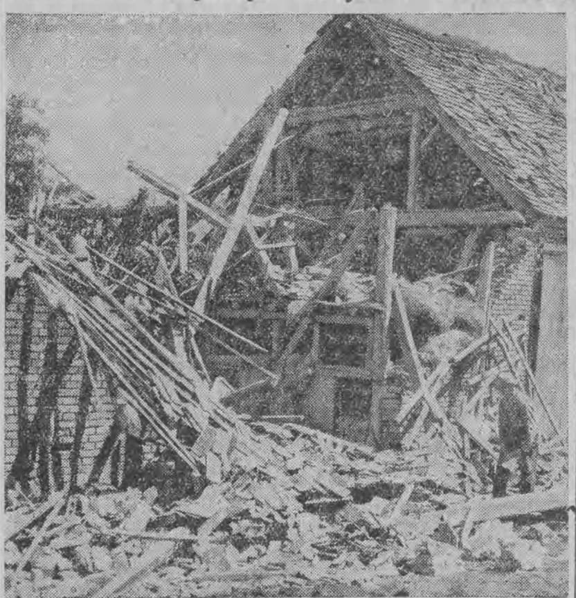
Zdjęcie nasze przedstawia zniszczoną skutkiem wybuchu okoliczną chatę wiejską.
