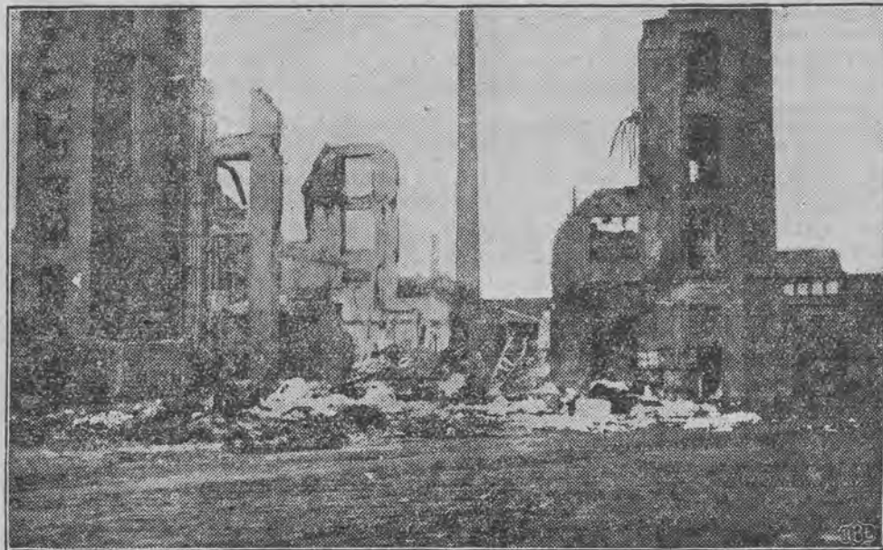
Zgliszcza spalonej fabryki L. Przygórskiego.
