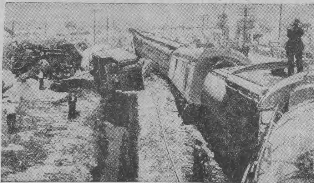
która nastąpiła w Kalifornji wskutek zderzenia pociągu pośpiesznego z towarowym, przyczem 4 osoby poniosły śmierć.
