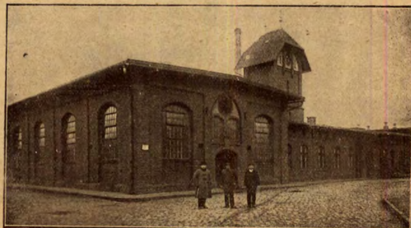
Budynek rzeźni miejskiej w Ostrowie Wlkp.
