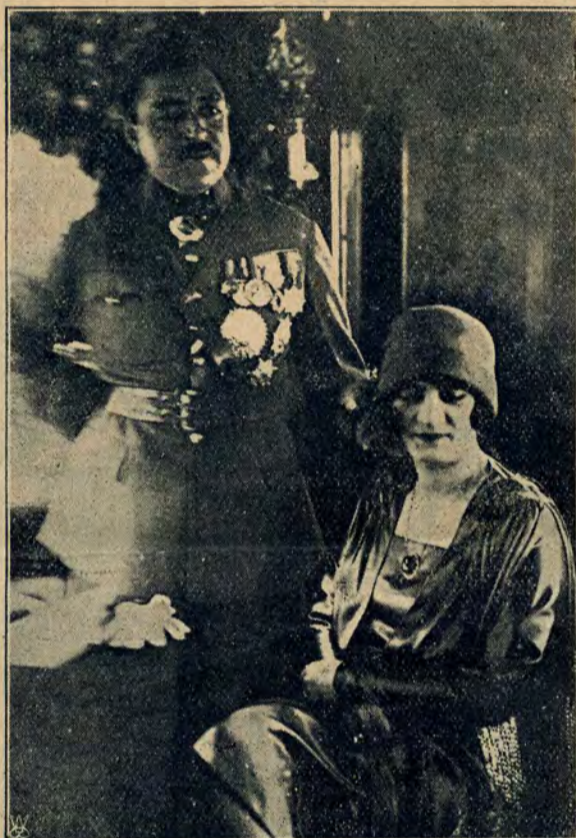
W drodze do Rosji Dostojna para w pociągu
