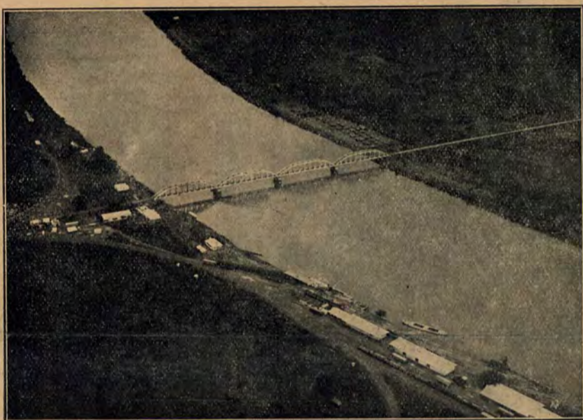
Bukama. Most kolejowy linii B. C. K.
