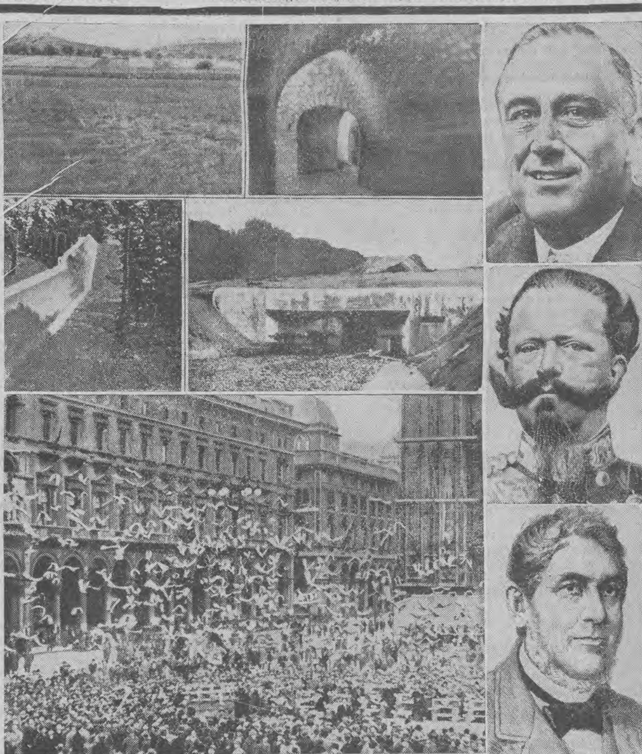
1. „Linja Maginota“. Nikt nie widzi na tym łagodnym terenie, że na głębokości 100 metrów ciągną się tutaj betonowe konstrukcje, tworzące prawdziwe miasto. U góry na prawo: Od fortu do fortu ciągną się podziemne korytarze łącznikowe, budowane specjalnie spiralami, aby nieprzyjacielskie karabiny maszynowe nie mogły objąć większych przestrzeni. U dołu na lewo: Szerokie mury betonowe ciągną się przez lasy, wskazując na bliskość podziemnej fortecy. U dołu na prawo: Wejście do podziemnego miasta fortecznego, stanowiące punkt wypadowy dla załogi podczas wojny. — 2. Tysiąc gołębi pocztowych zaniosło Mussoliniemu z Medjolanu do Rzymu wyrazy hołdu w rocznicę utworzenia partji faszystowskiej. — 3. Roosevelt będzie ponownie kandydował przy wyborach prezydenta Stanów Zjednoczonych. — 4. Wiktor Emanuel II został w marcu przed 75 laty proklamowany pierwszym królem zjednoczonych Włoch. — 5. Robert Bunsen, jeden z najwybitniejszych chemików ubiegłego stulecia, urodził się w Getyndze, 31 marca przed 125 laty.
