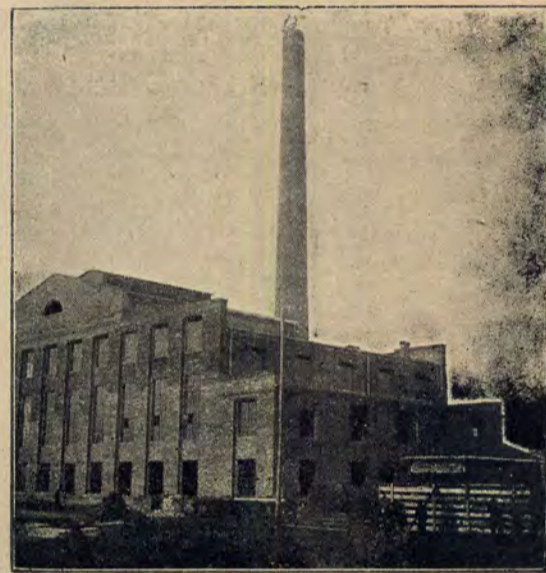
Nowa miejska elektrownia w Płocku.
