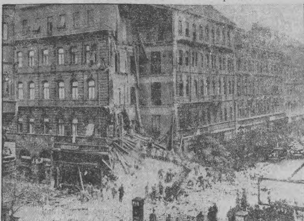
Na zdjęciu widoczny fronton czteropiętrowego domu, który się zawalił. Podczas katastrofy zginęły 4 osoby, a kilkadziesiąt osób odniosło rany.
