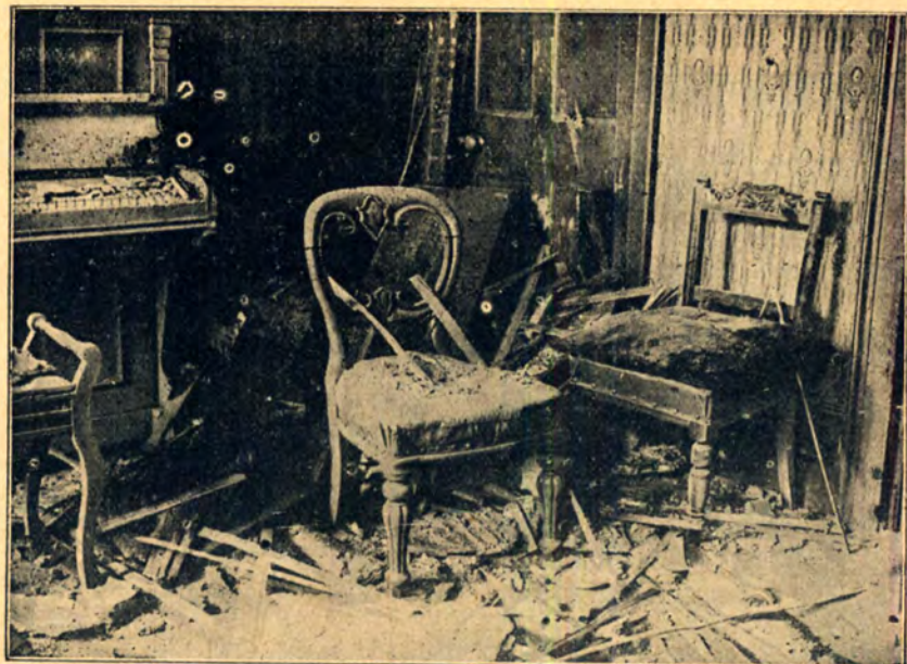
Jedno z mieszkań w części miasta, w której miał miejsce wybuch, po katastrofie.
