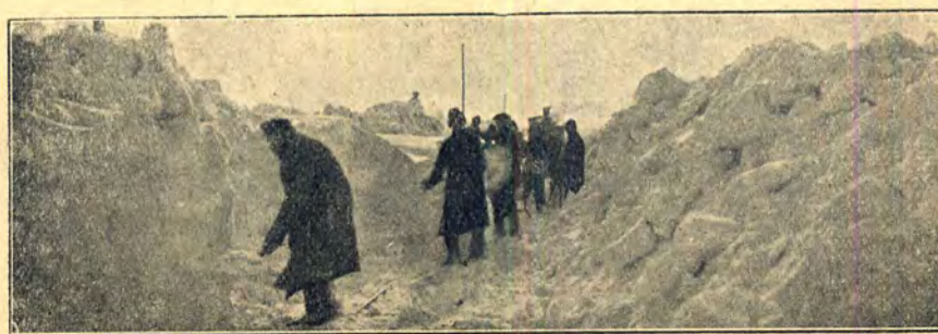
200 robotników odkopuje tor kolejowy kolejki kalisko-tureckiej
