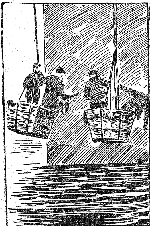
Jeden z mostów kolejowych w Londynie, jest obecnie odnawiany. Robotnicy, zajęci przy malowaniu filarów, zawieszani są w koszach ponad wodą, jak to widzimy na naszej ilustracji.
