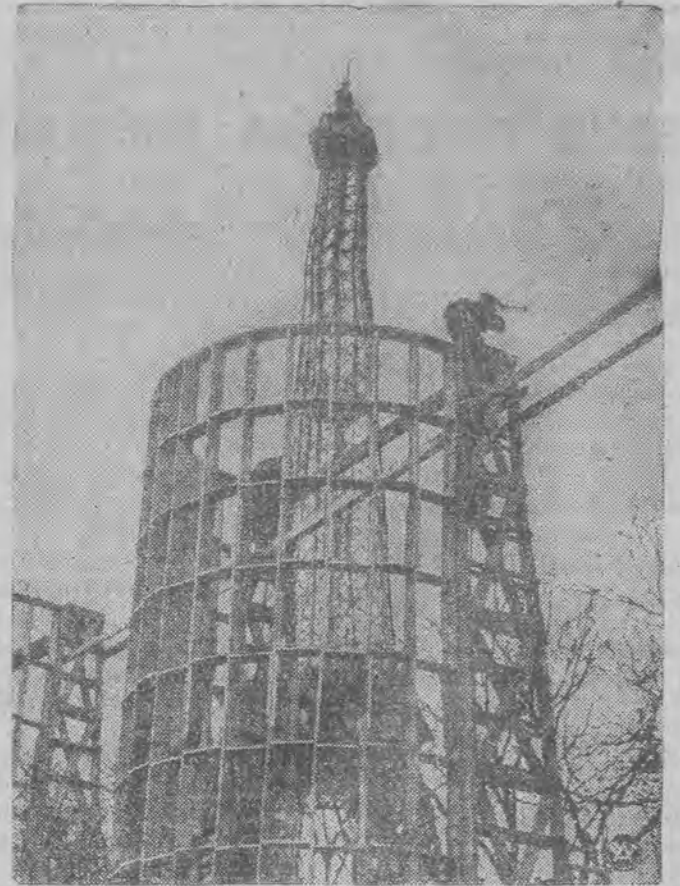
Stalowy szkielet jednej z olbrzymich hal na wystawie światowej w Paryżu imitujący do złudzenia wieżę Eiffla „w opakowaniu”. —
