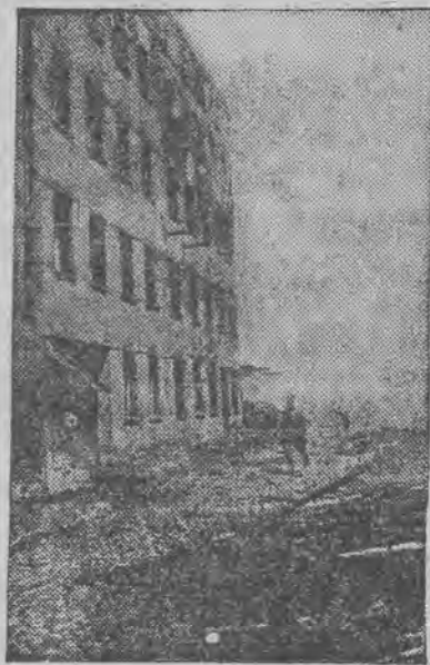
Dom przy ul. Berka Joselewicza 4, doszczętnie spłonął. 50 rodzin utraciło dach nad głową.
