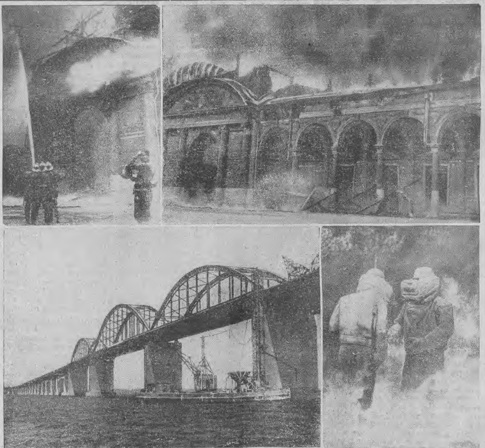
1-2 Olbrzymi pożar w Wiedniu zniszczył, jak wiadomo, słynną „Rotunde“, która była największym budynkiem na wystawie światowej w 1873 roku i do ostatniej chwili służyła za pomieszczenie dla wystaw próbek, targów etc. — 3. Najdłuższy most w Europie między wyspami Seeland i Falster w Danii, mierzący przeszło trzy kilometry długości, został w tych dniach oddany do użytku. — 4. Kostiumy azbestowe, w które wyposażeni są uczniowie szkoły strażackiej w Anglii, pozwalają zupełnie bez szkody przechodzić przez morze płomieni. —
